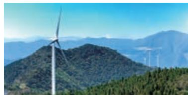
第二中九州大仁田風力発電所
